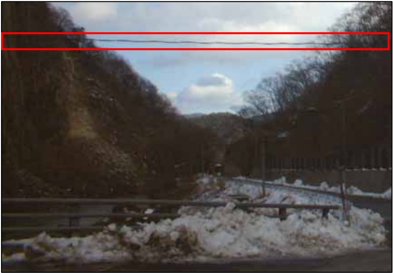
写真1 電線施設の設置 (阿武隈川水系白石川:宮城県白石市) 関係発電所:刈田発電所
