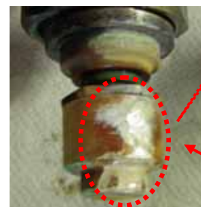
当該ドレン弁 (弁体) 状況写真
