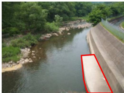
写真4 護岸の根固め工
