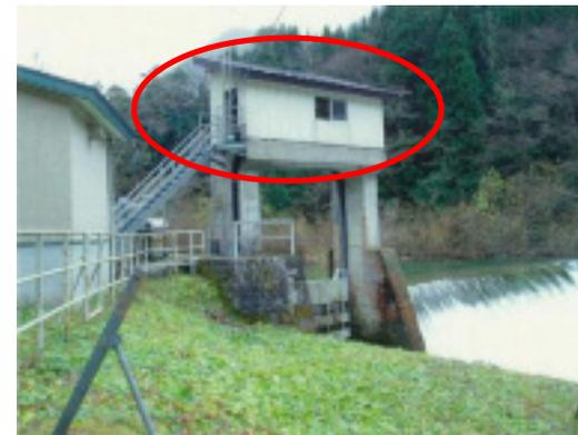
写真3 えん堤排砂ゲート巻上機上屋の設置
