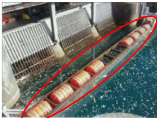
写真5 ポンツーン(ゴミ除け浮函)の設置
