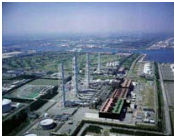
東新潟火力発電所
