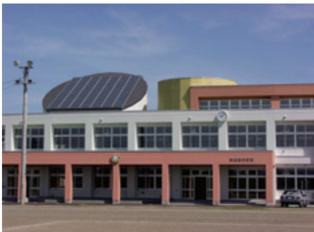
東北グリーン電力基金の助成金を利用して、 田舎館中学校（青森県田舎館村）に設置 された10kW級太陽光発電設備
