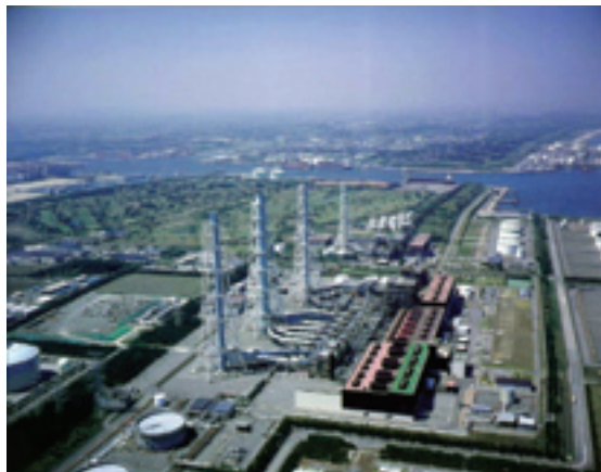
東新潟火力発電所
