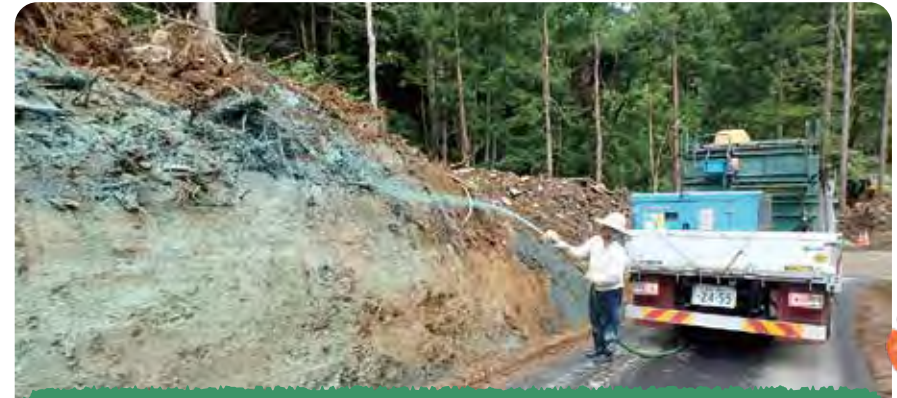
鉄塔工事後の緑化
