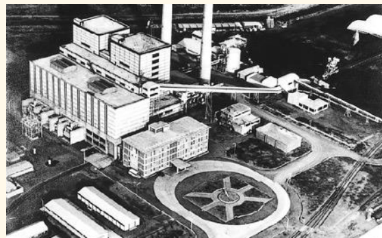
八戸火力発電所1号機 運転開始（1958年）
