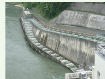
ダムに設置されている魚道
