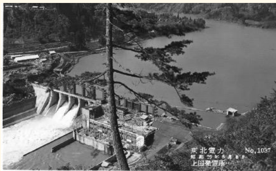
上田発電所建設（1954年）
