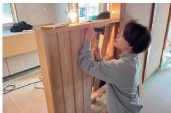
玄能を使って釘を打ち込む
