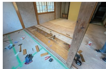
フローリング張りの様子
