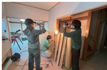
壁の板張り作業の様子
