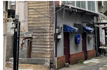
取得したスナック跡地の空き店舗(外観)
