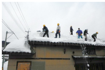
安全帯を装着して屋根上作業
