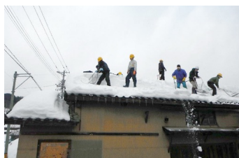
安全帯を装着して屋根上作業
