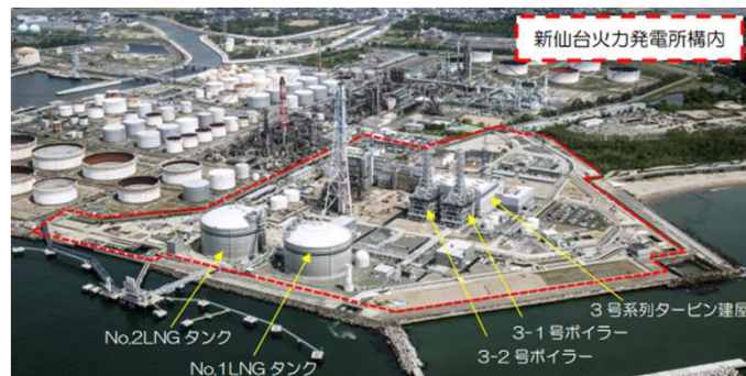
新仙台火力発電所3号系列
