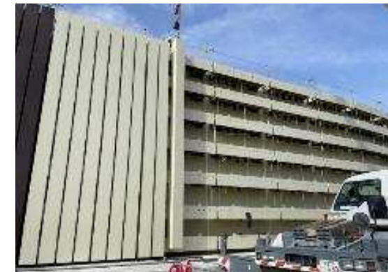
防潮堤かさ上げ工事
