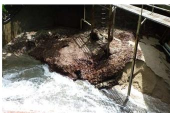
写真1 水槽土砂堆積状況 (現状)
