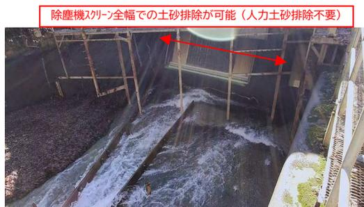
写真2 実機検証状況
