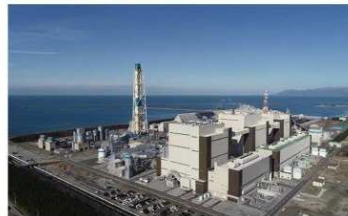
能代火力発電所
