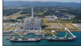
石炭船を受け入れるために作られた専用港です。港の水深は1.4m、長さは600mあり、200m級の石炭船2隻が停泊できます。防波堤の長さは合わせて3kmあります。
