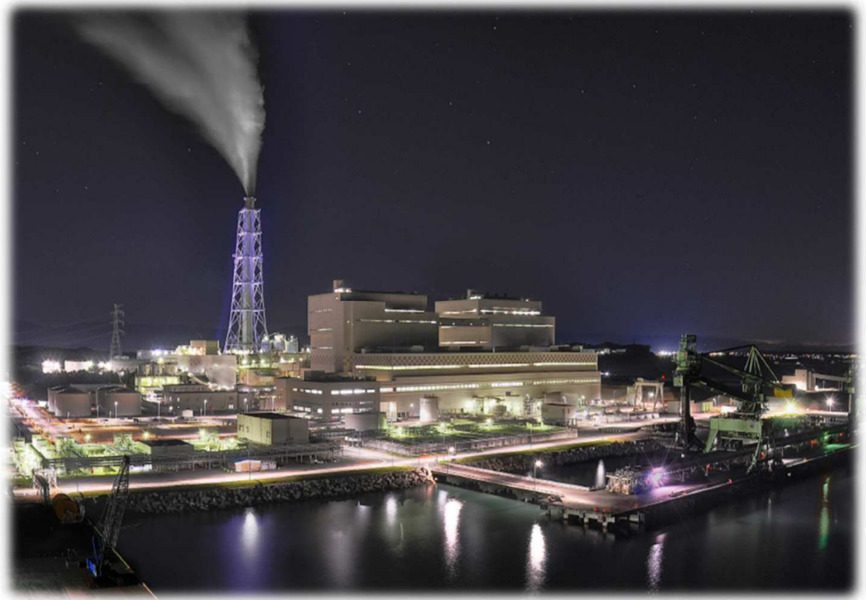
発電所の夜景
