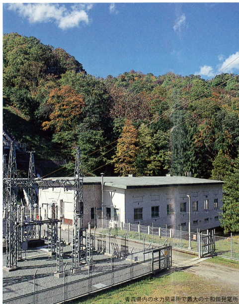
青森県内の水力発電所で最大の十和田発電所
