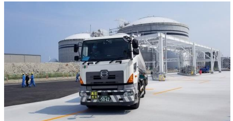
新仙台火力発電所のLNG出荷設備
