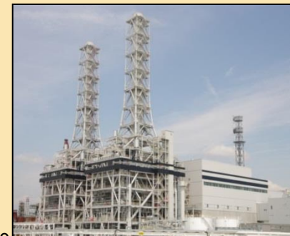
新仙台火力発電所3号系列
