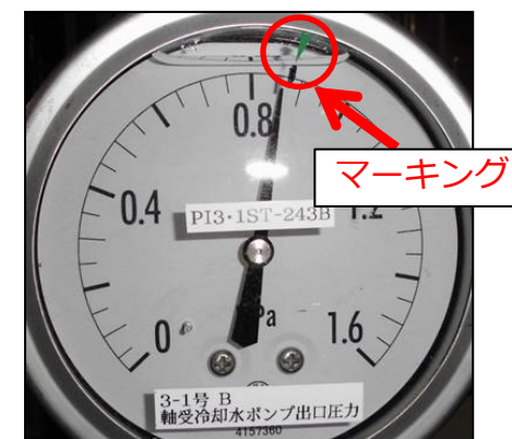
現場の機器に標準値をマーキングし、設備状態の把握を強化
