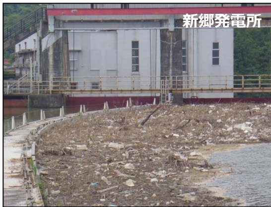
河川の流量増加に伴い、大量に押し寄せた流木・葉・生活ゴミなどの塵芥
