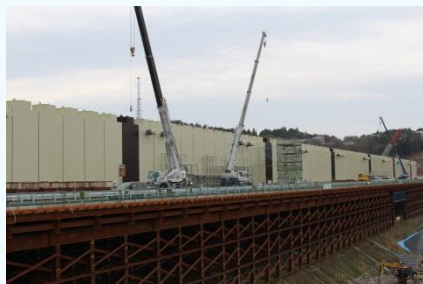
約29mの防潮堤工事が進む 女川原子力発電所。
