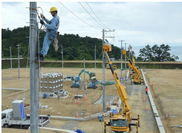
石巻市給分浜の造成地への電力供給工事 (平成27年7月)
