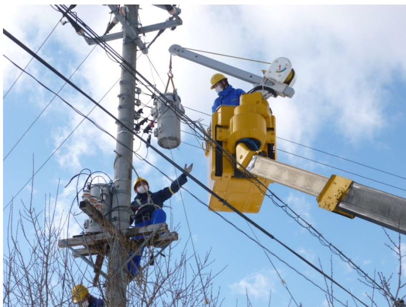
福島県大熊町での柱上変圧器の交換作業 (平成28年2月)
