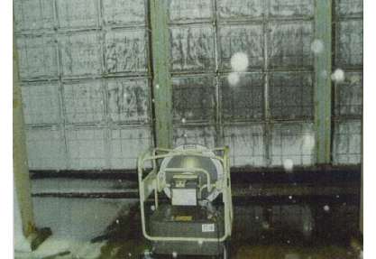
パトロールを強化し、着雪を確認した際には速やかにヒーターや手作業で除去
