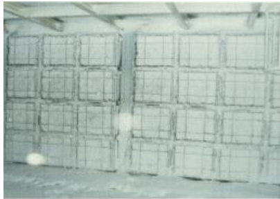
ガスタービンの空気の取り入れ口に雪が付着すると、発電出力に影響
