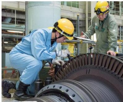
【写真①】 設備点検の実施状況
