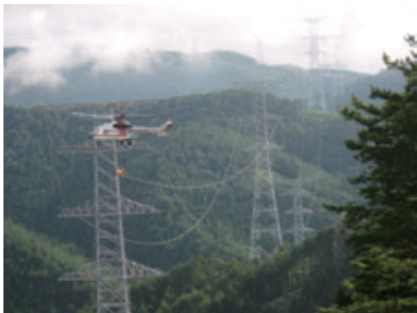
北上幹線 ヘリによるナイロンロープ延線状況
