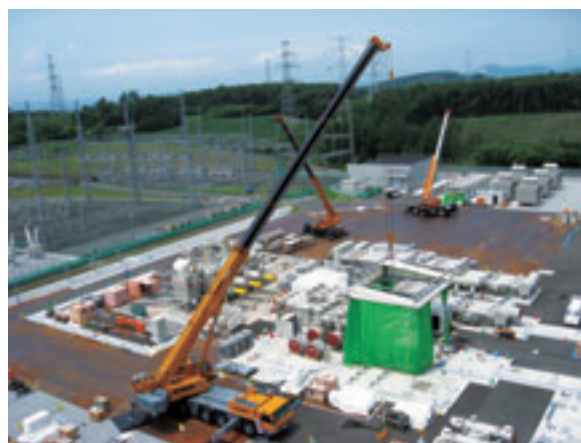
岩手変電所 500kV 機器据付作業状況
