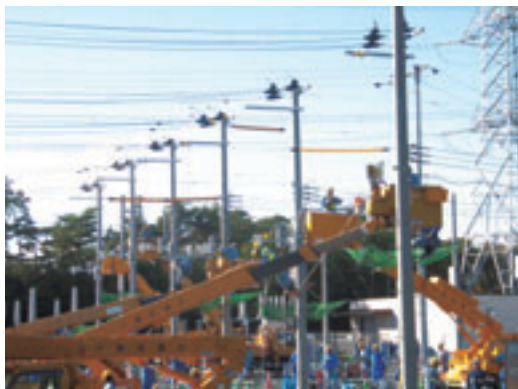
配電設備の「災害復旧作業」を想定した技能競技大会
