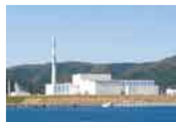
当社東通原子力発電所 1 号機
