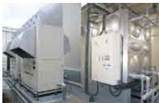
＜ハイブリッド式エコキュート＞ 写真左：熱源機、同右：貯湯タンク
