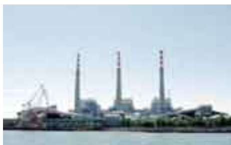
仙台火力リブレース前
