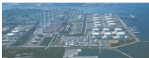
【写真は当社東新潟火力発電所と 日本海エル・エヌ・ジー株式会社新潟基地】
