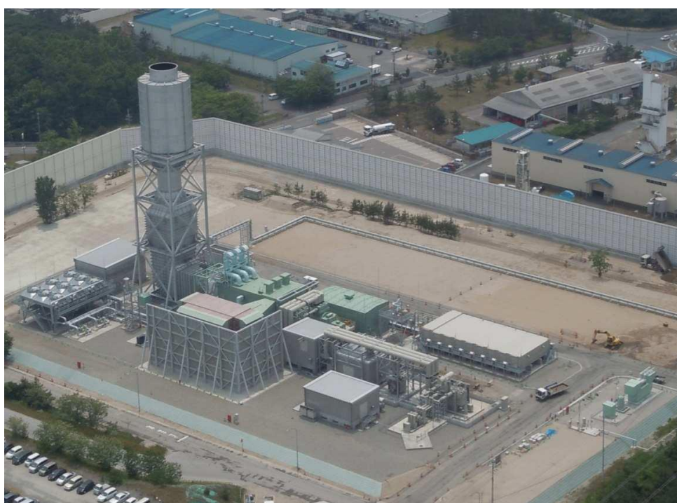
5 号機発電設備の全景
