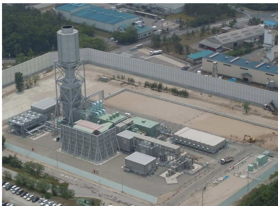
5 号機発電設備の全景
