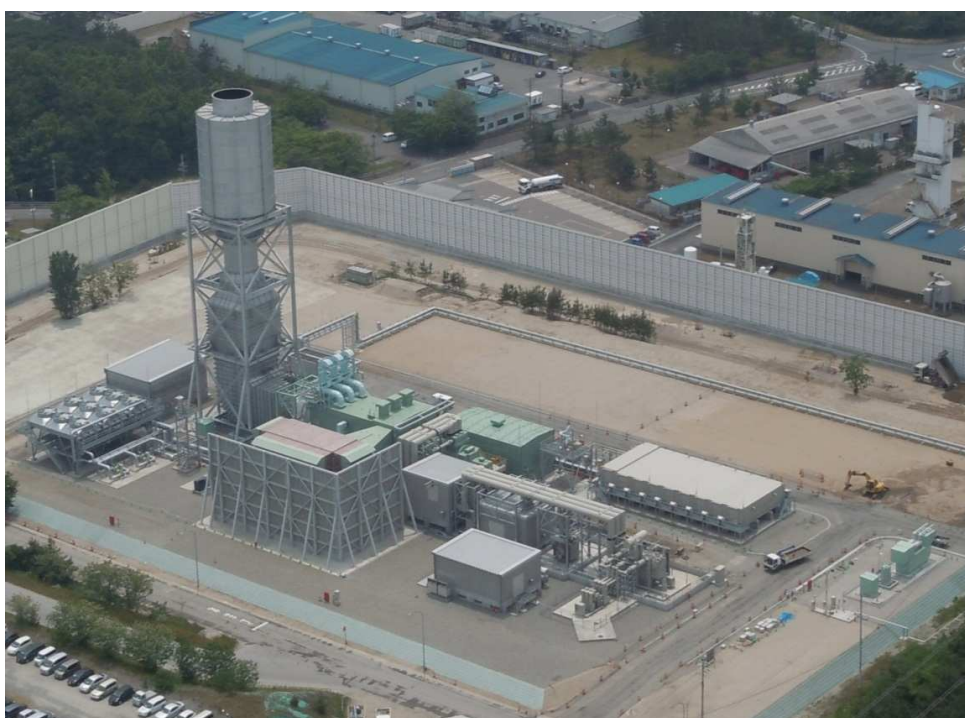
5 号機発電設備の全景
