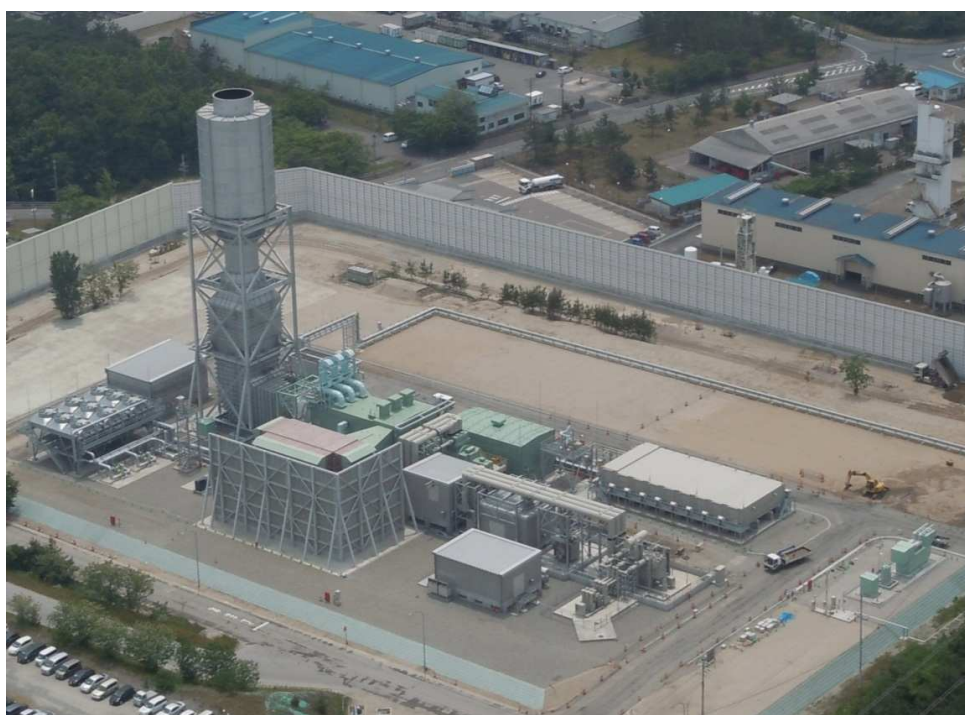
5 号機発電設備の全景
