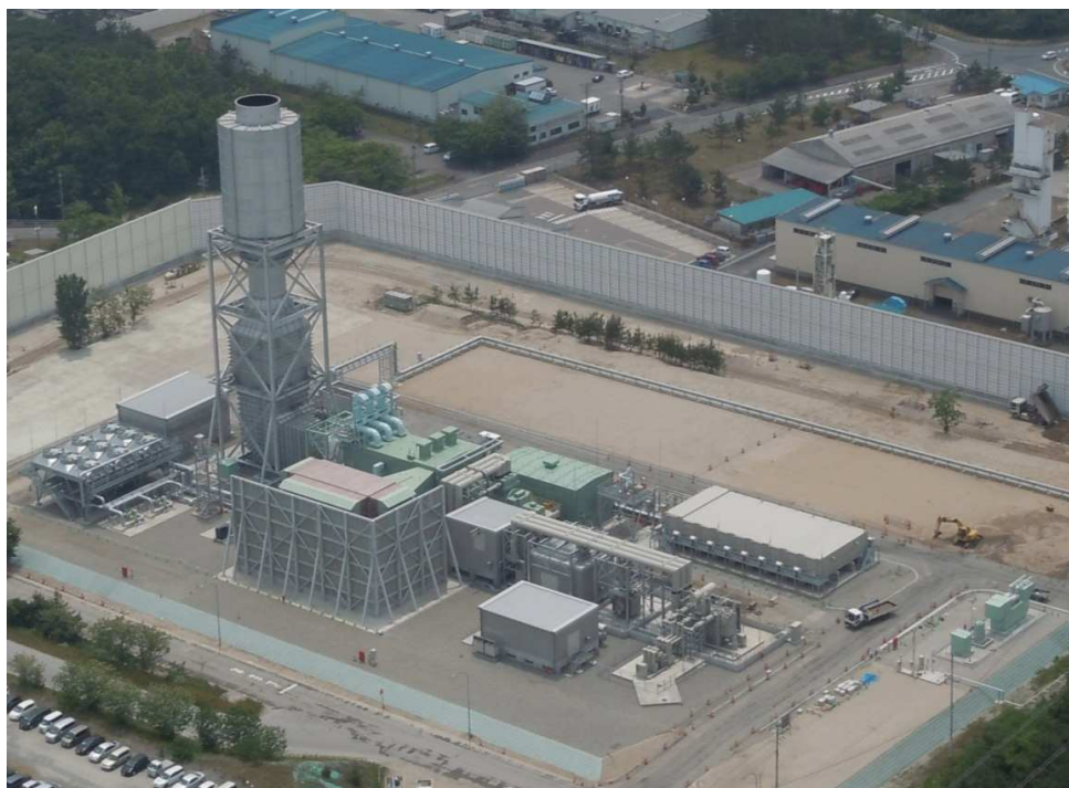
5 号機発電設備の全景
