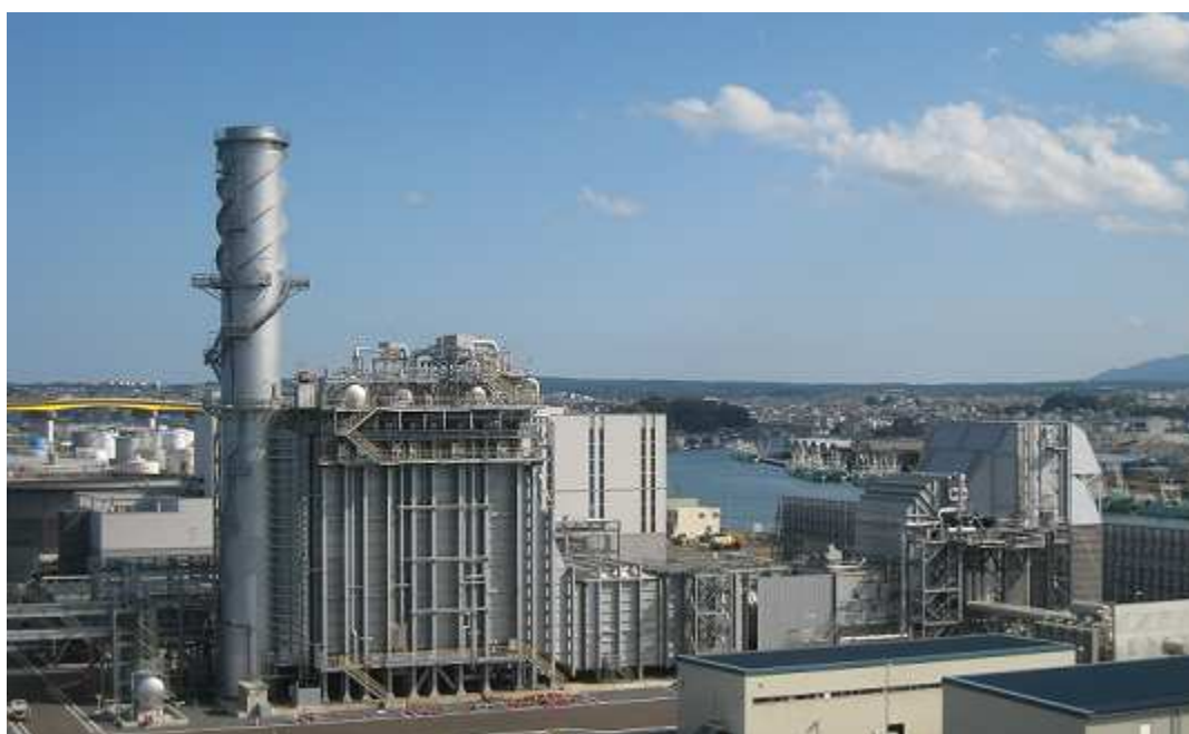
排熱回収ボイラ・蒸気タービン建屋（平成 26 年 10 月 1 日撮影）
