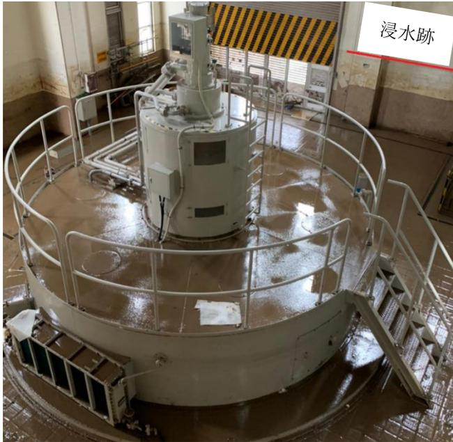
② 夏井川第三発電所 取水口自動制御盤冠水状況
