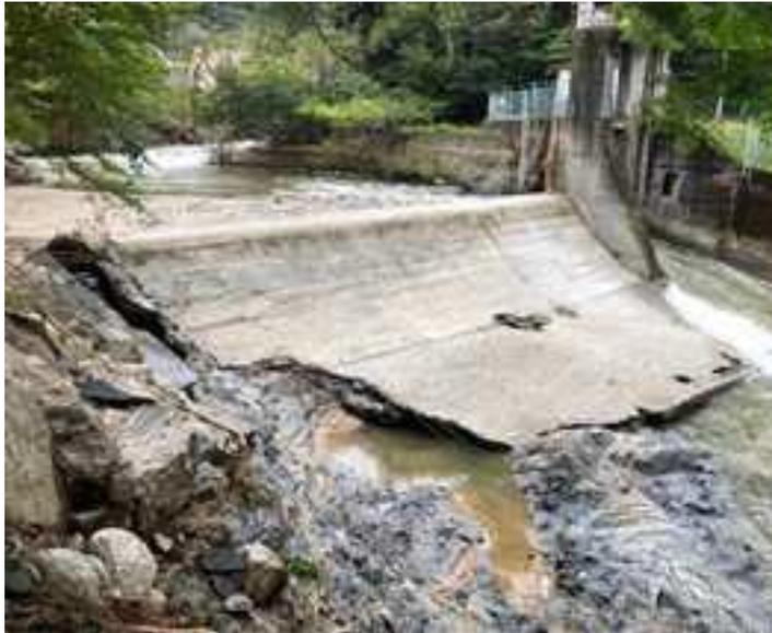
④ 上田発電所 取水口等関連機器損傷（流木堆積）状況
