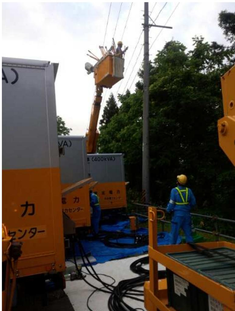
高圧電源車による応急送電の様子 (鶴岡市内)
