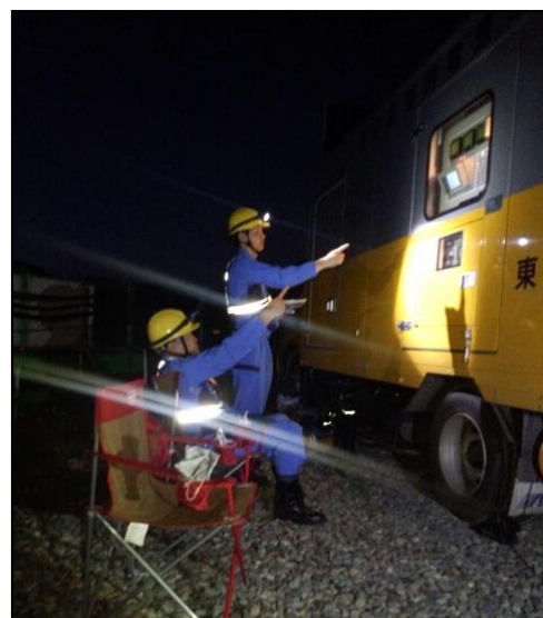
夜間作業の様子
