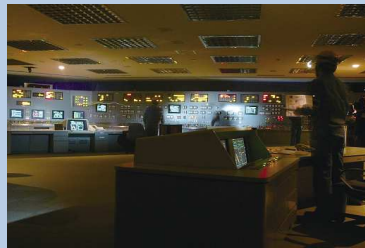
全交流電源喪失時を想定したシミュレーターによる運転操作訓練
