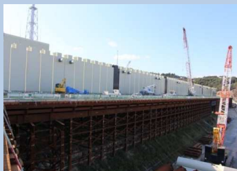
約29mの防潮堤工事が進む女川原子力発電所
