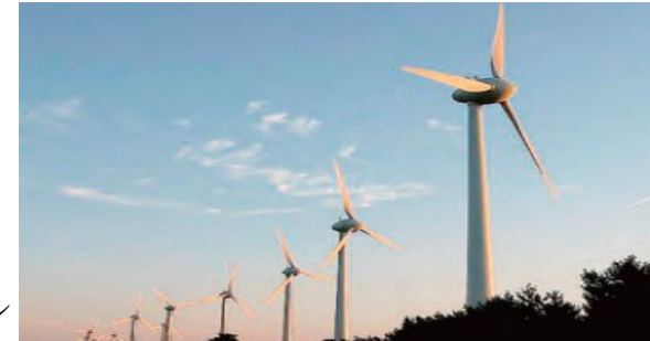
能代風力発電所 (東北自然エネルギー株式会社)
