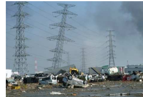
[傾斜した鉄塔(宮城県多賀城市)]
