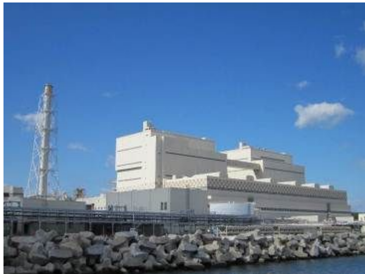
◇ 被災前後の設備（左：震災直後 右：復旧後） 事務所
