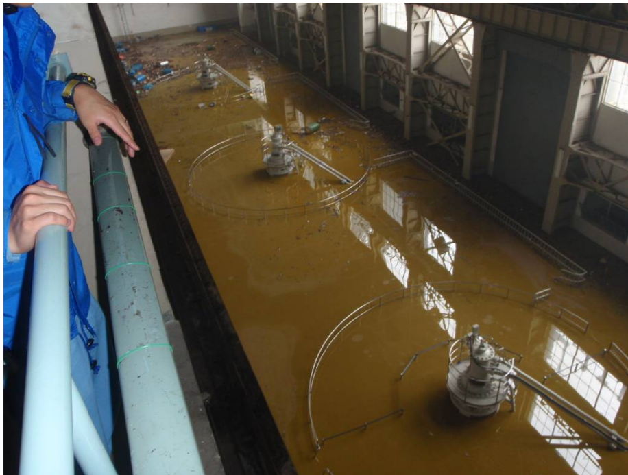
④ 上田発電所 発電機浸水状況 (7/30)
