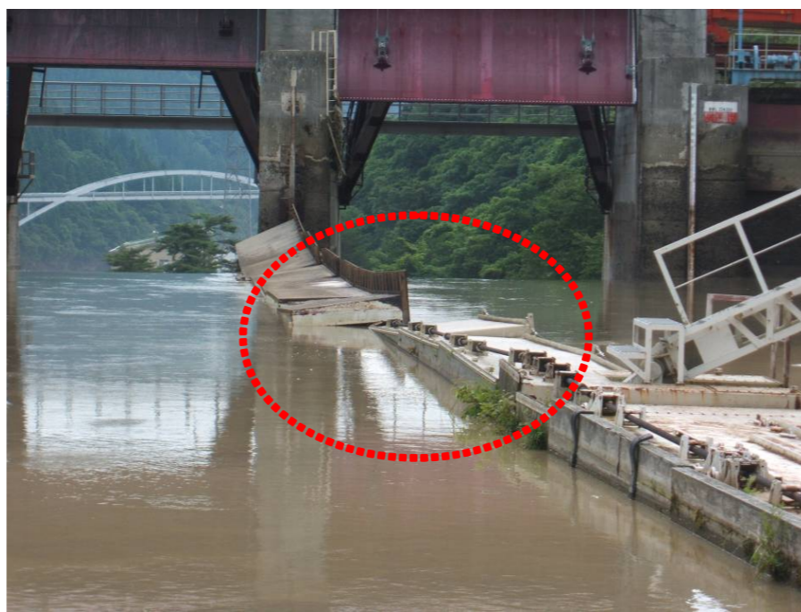
⑪ 第二新郷発電所 放水口付近 (土砂堆積状況)
