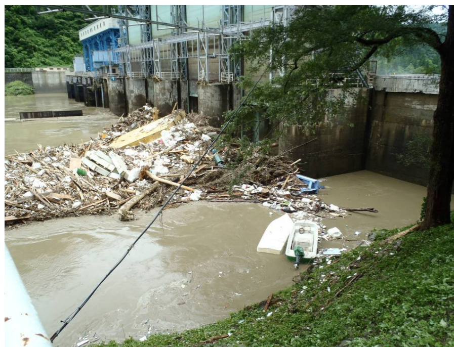
⑩ 新郷発電所 放水口付近 (土砂堆積状況)
