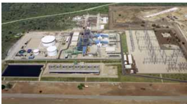
アルタミラ II 発電所
