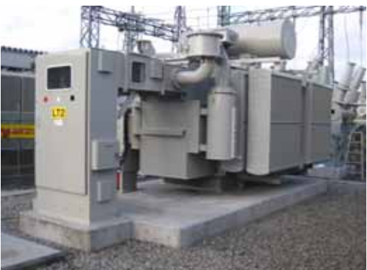
（参 考）梁川変電所に導入した「環境調和型変圧器」の概要について
