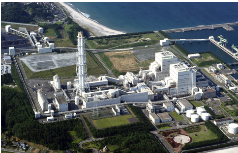
＜原町火力発電所＞
