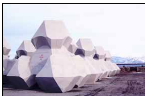
（図２）フライアッシュ混合コンクリートで 製造された消波ブロック
