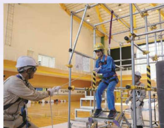
脚立の上でバランスを崩し転倒する危険性を体感
