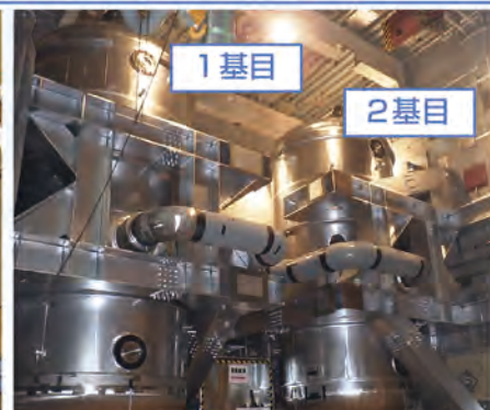
2 2019年2月までに2基の据付工事が完了した。
