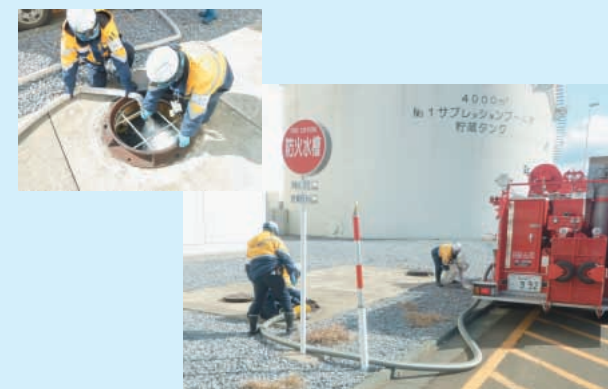
冷却機能が失われた原子炉を冷やすため、消防車による注水作業を行った
