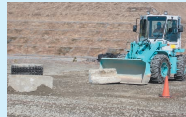
電源車や消防車などの移動通路を確保するため、ホイールローダで散乱するがれきを除去した
