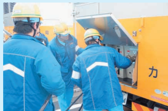
電源を失った発電所設備へ電力を供給するため、電源車を接続する作業を行った
