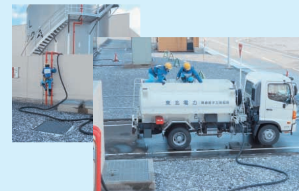
電源車や消防車などへ燃料を補給するため、燃料タンクからタンクローリー車へ燃料を移し替える作業を行った
