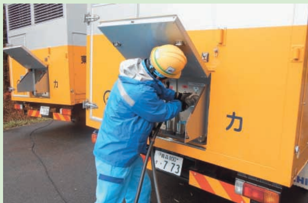
電源を失った発電所設備へ電力を供給するため、電源車と配電線を接続する作業を行った
