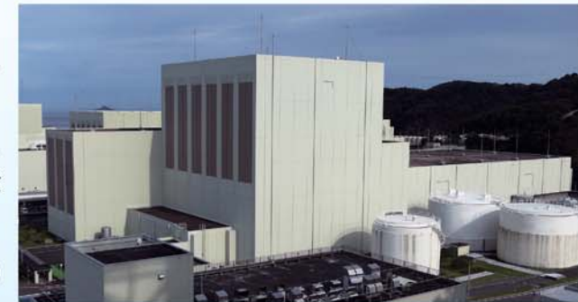
女川原子力発電所1号機
