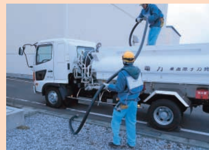
大容量電源装置や電源車などへの燃料補給のため、燃料貯蔵タンクからタンクローリーへ燃料を移し替える様子
