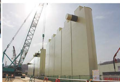
防潮堤を構成する鋼管杭の上杭部分
