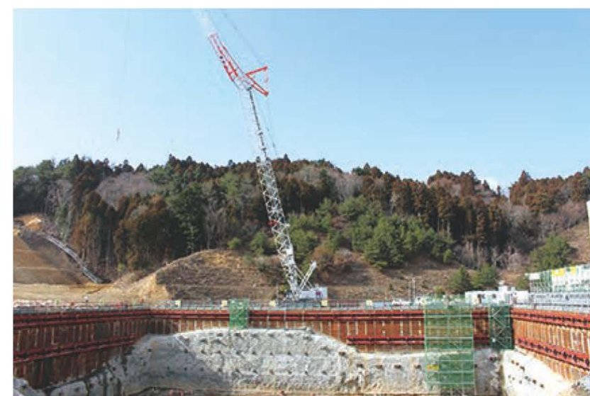
設置工事が進む淡水貯水槽
